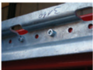
Joonis 11. Ankurdamis-siin
